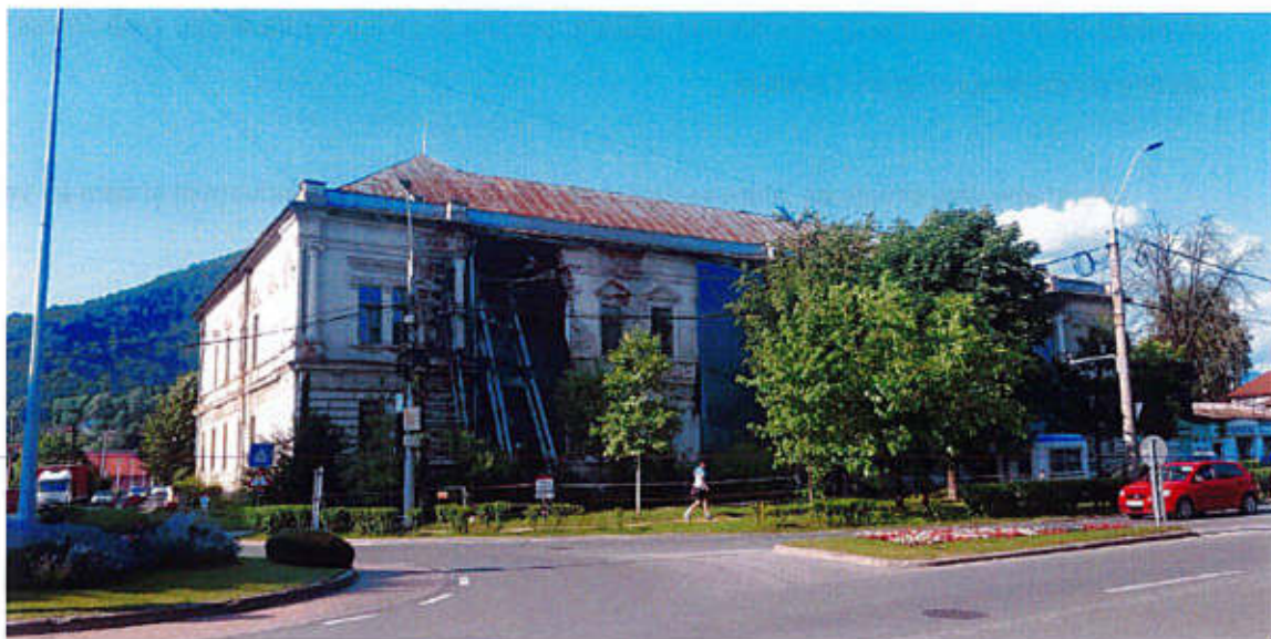
Fig. 6 - Fațada principală a clădirii monument.
